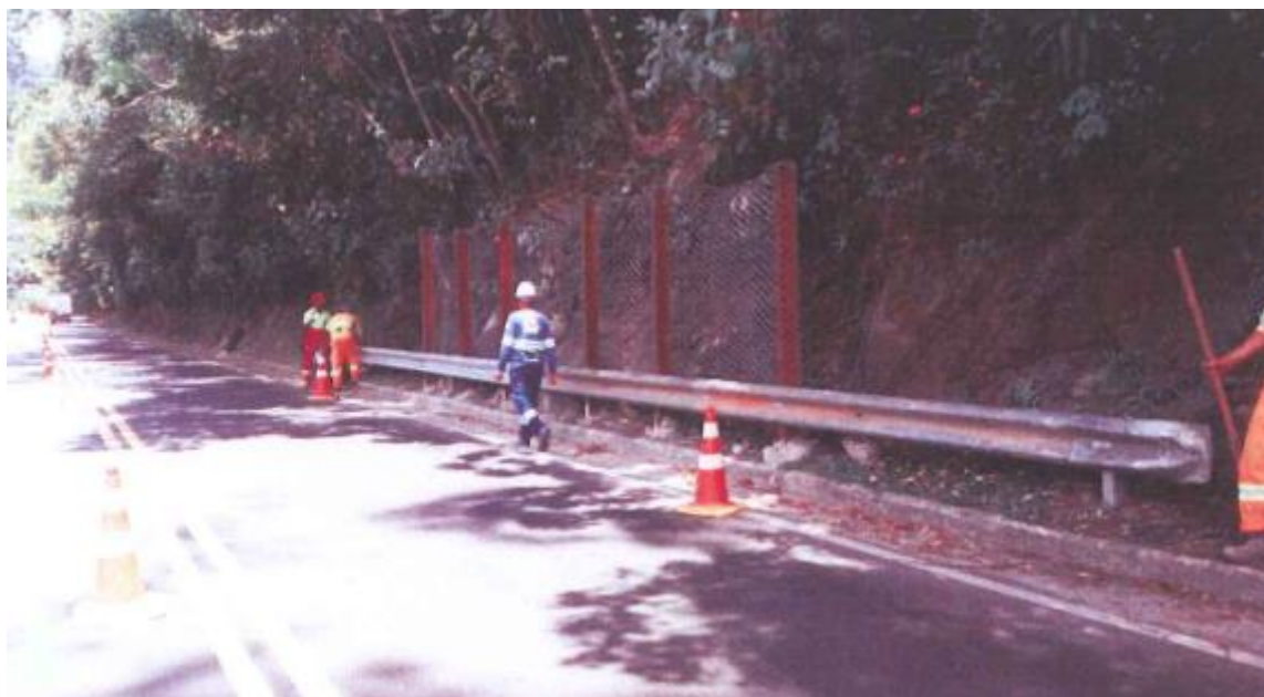
Foto 9 – Implantação de dispositivo de segurança – Km 073+300 [1]
