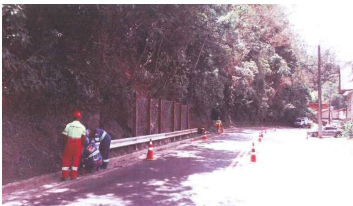
Foto 10 – Implantação de dispositivo de segurança – Km 073+300 [2]
