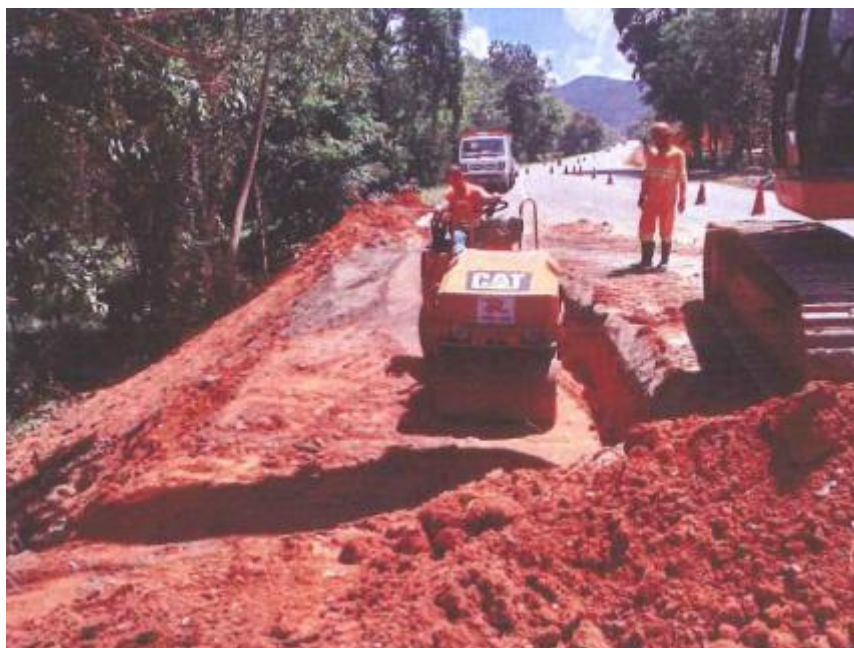
Foto 1 – Restauração de drenagem – Km 014+000 [1]
