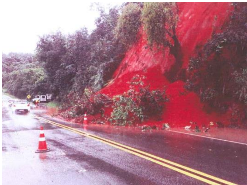
Foto 5 – Queda de barreira – Km 034+400 [1]
