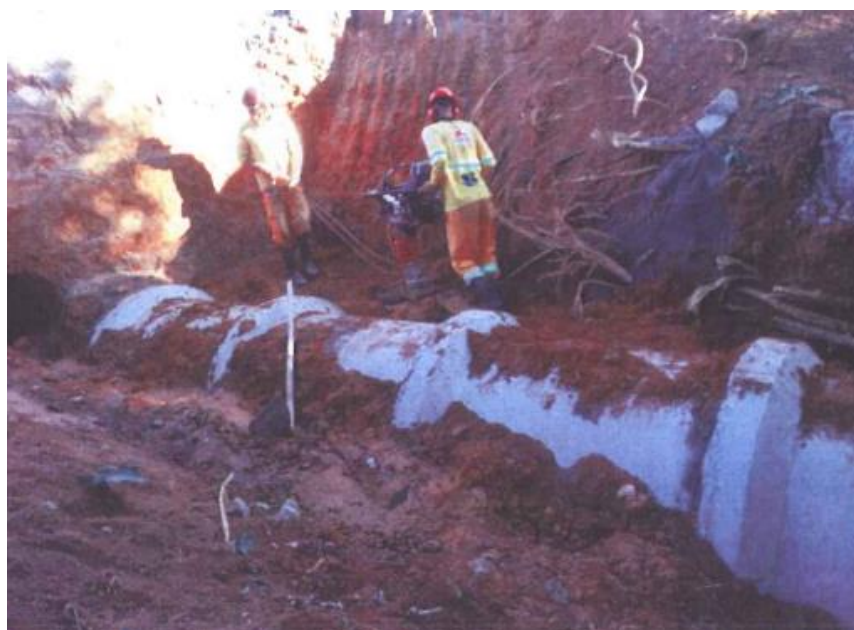
Foto 2 – Restauração de drenagem – Km 014+000 [2]
