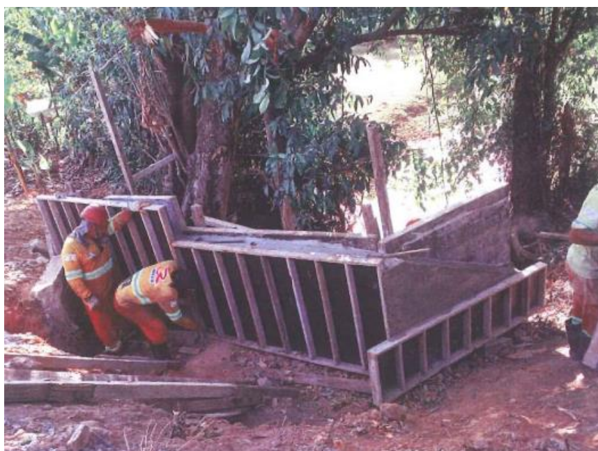
Foto 4 – Restauração de drenagem Km 036+000 [4]
