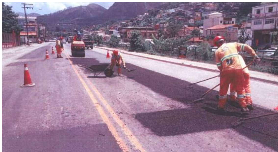
Foto 12 – Reparos no pavimento – Km 088+000
